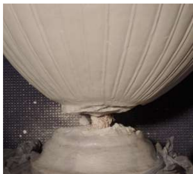
Fig. 15. Vaso Neoático. Detalle del estado de la unión con perno de hierro.
